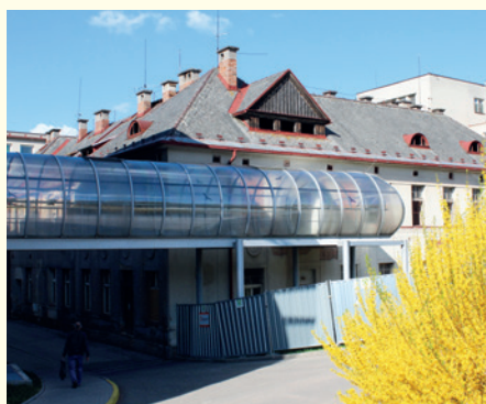
hospodářská budova určená k demolici
